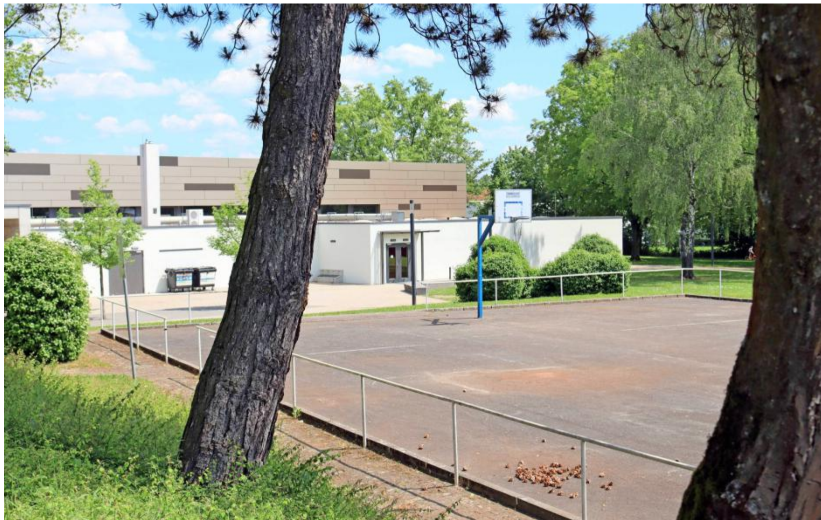
Der dritte Bauabschnitt beinhaltet die Umgestaltung des bestehenden Streetballfeldes. Hier entsteht ein neuer Sport- und Bewegungspark.
